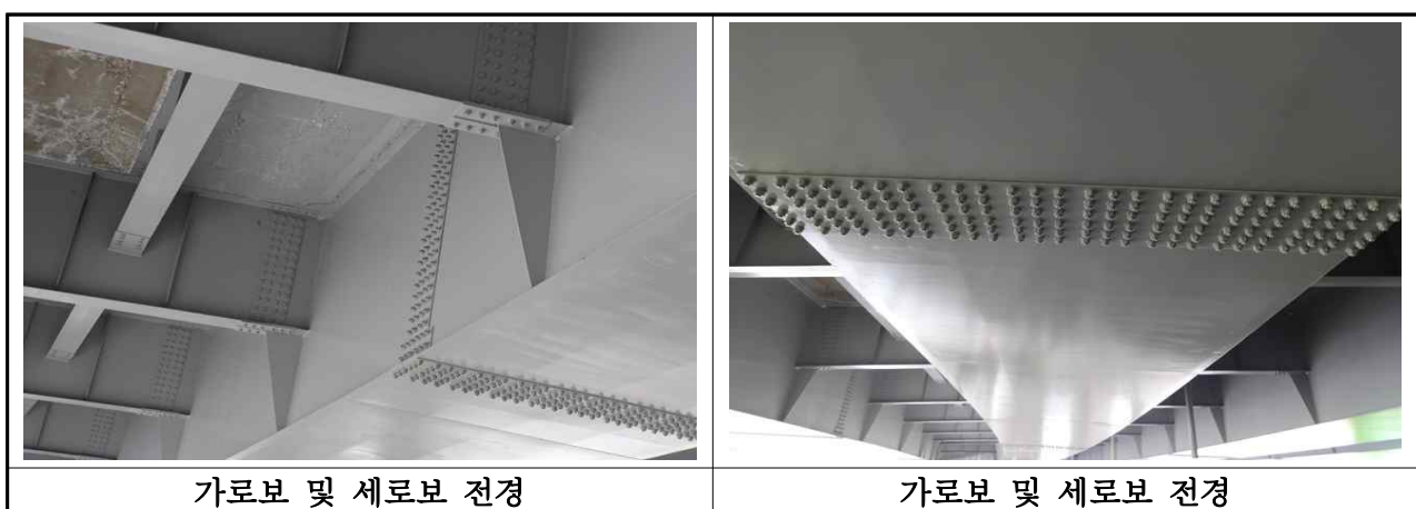
【사진 3.32】 가로보 및 세로보 전경
