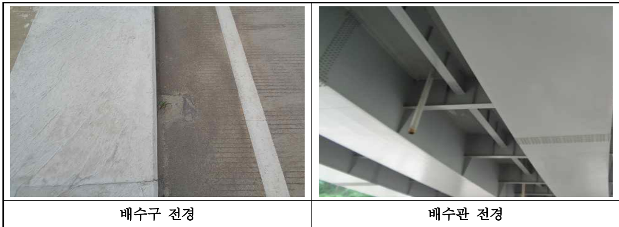
【사진 3.22】 배수시설 전경
