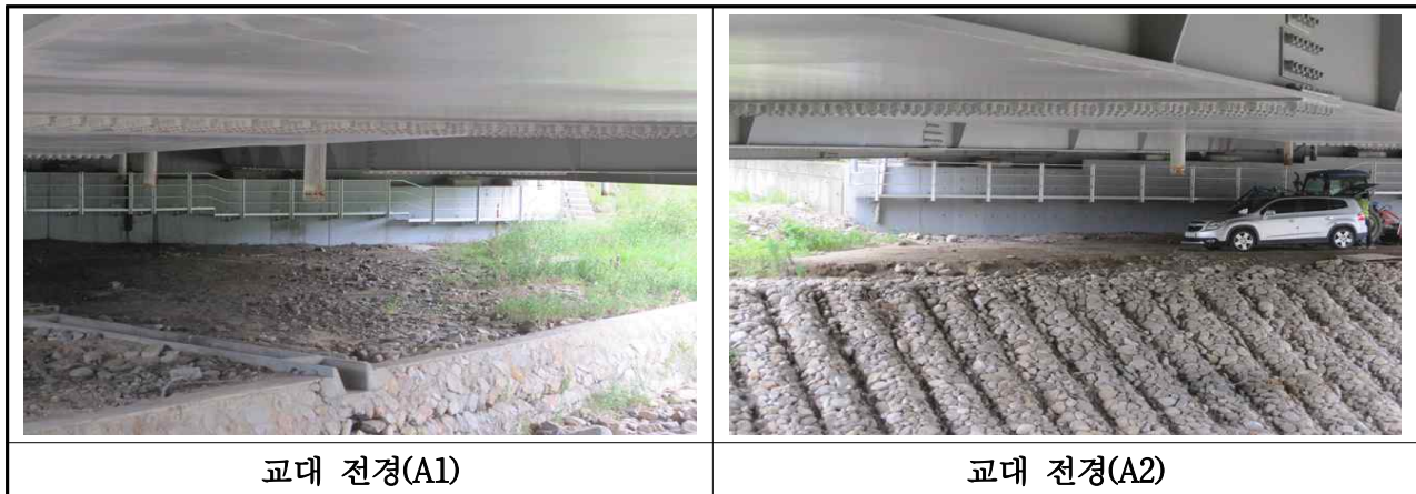
【사진 3.34】 교대 전경
