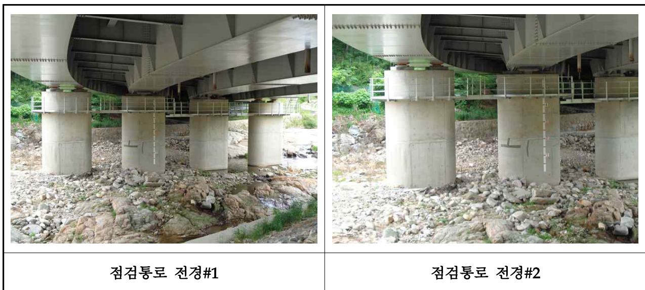
【사진 3.26】 교량 점검시설 전경
