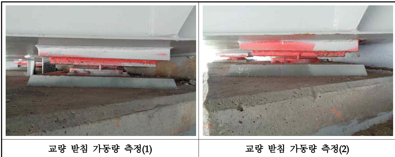
【사진 3.40】 교량받침 이동량 측정
