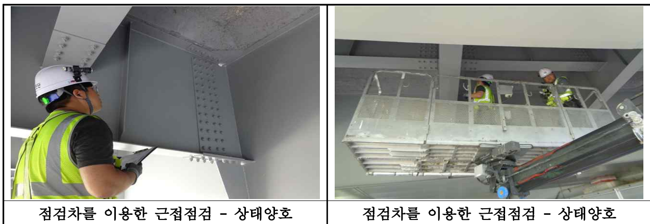
【사진 3.8】 가로보 및 세로보 손상현황
