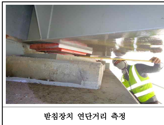
【사진 3.15】 교량받침장치 연단거리측정
