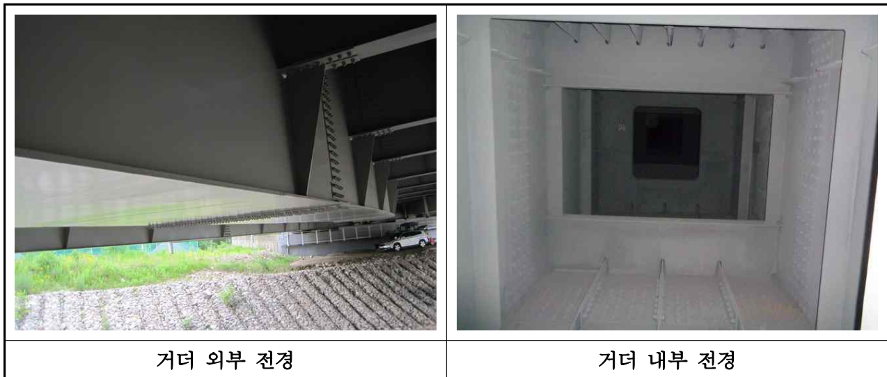
【사진 3.29】 거더 전경
