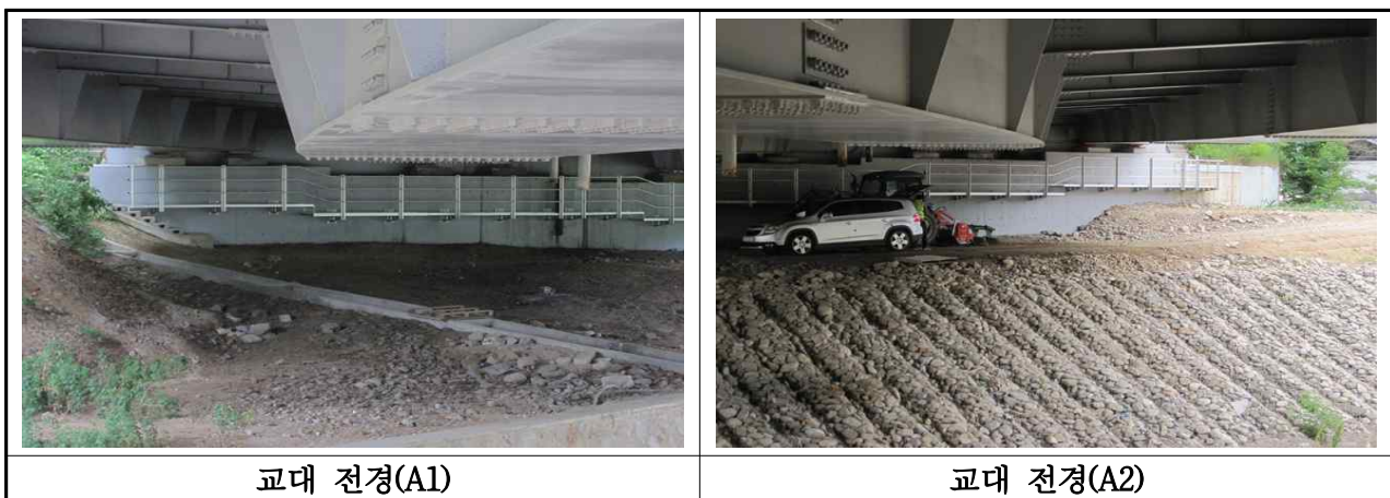
【사진 3.9】 교대 전경
