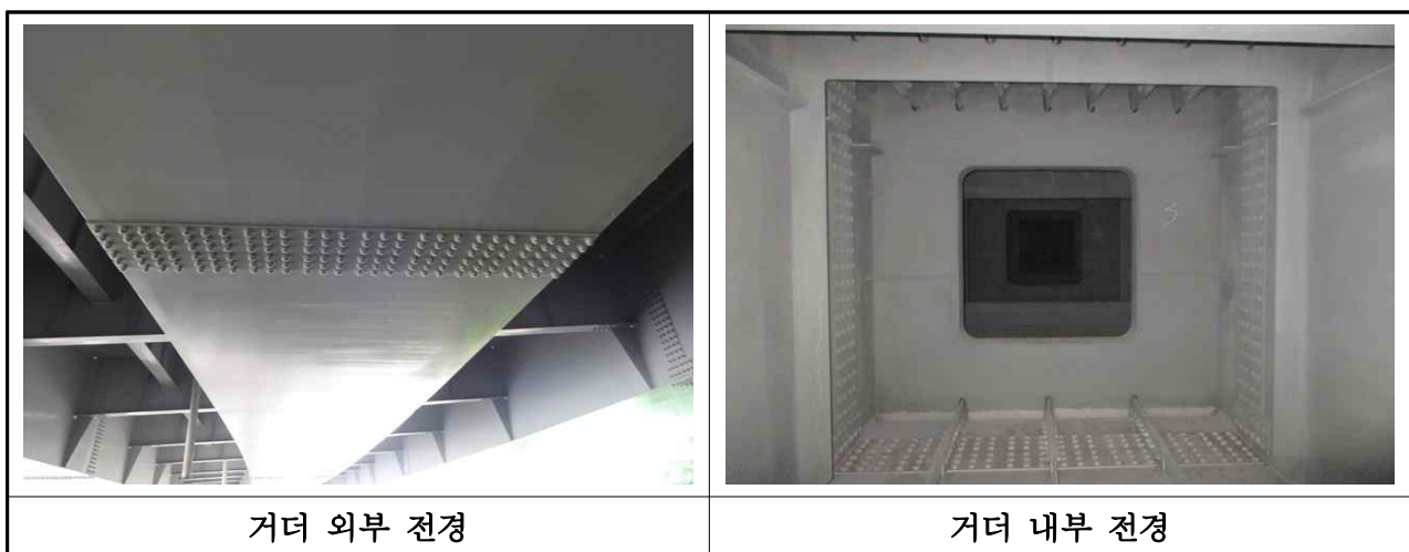
【사진 3.4】 거더 전경
