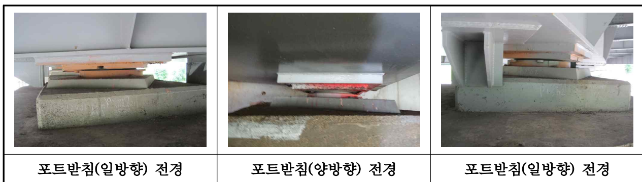
【사진 3.13】 교량받침 전경
