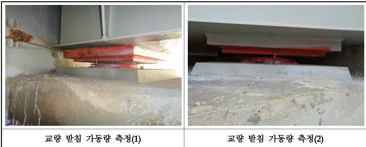
【사진 3.16】 교량받침 이동량 측정
