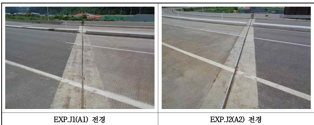
【사진 3.17】 신축이음장치 전경
