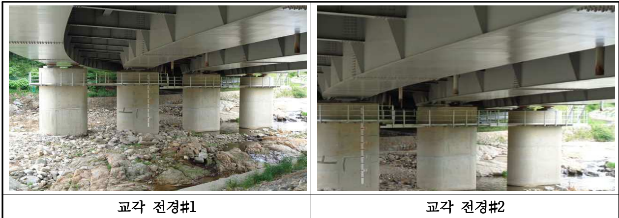
【사진 3.36】 교각 전경
