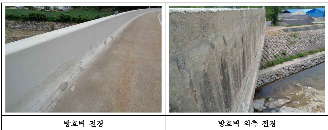
【사진 3.24】 방호벽 및 중앙분리대 전경
