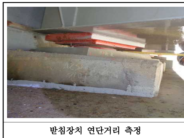
【사진 3.39】 교량받침장치 연단거리측정
