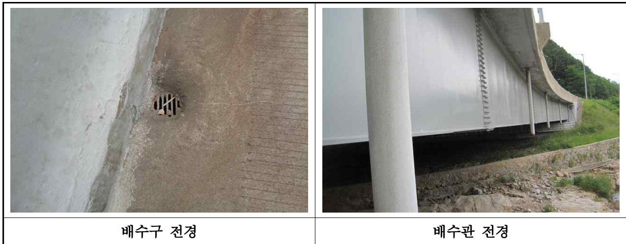
【사진 3.46】 배수시설 전경
