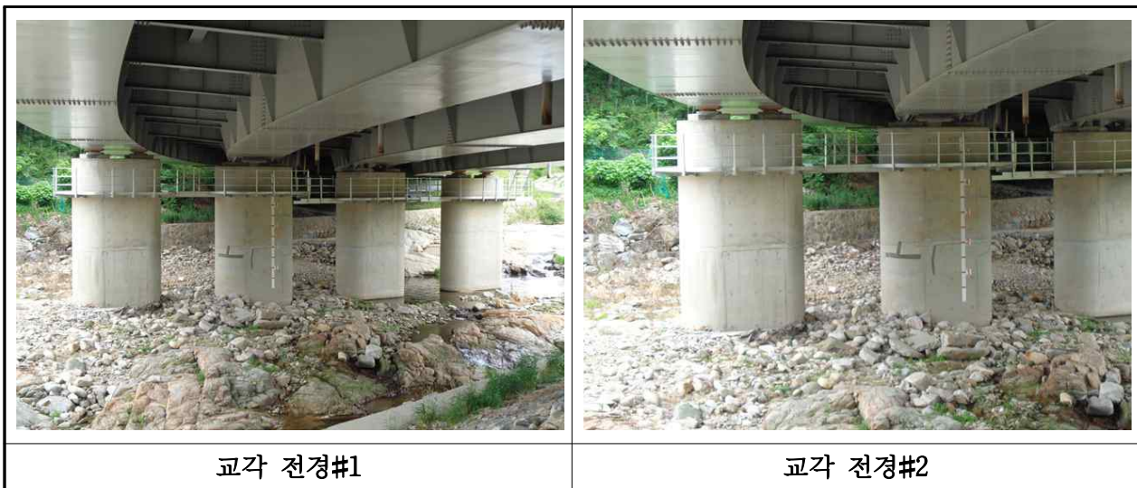
【사진 3.11】 교각 전경
