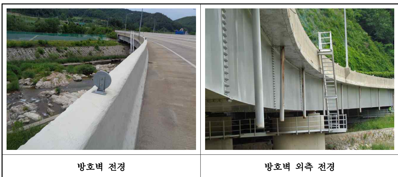
【사진 3.48】 방호벽 및 중앙분리대 전경
