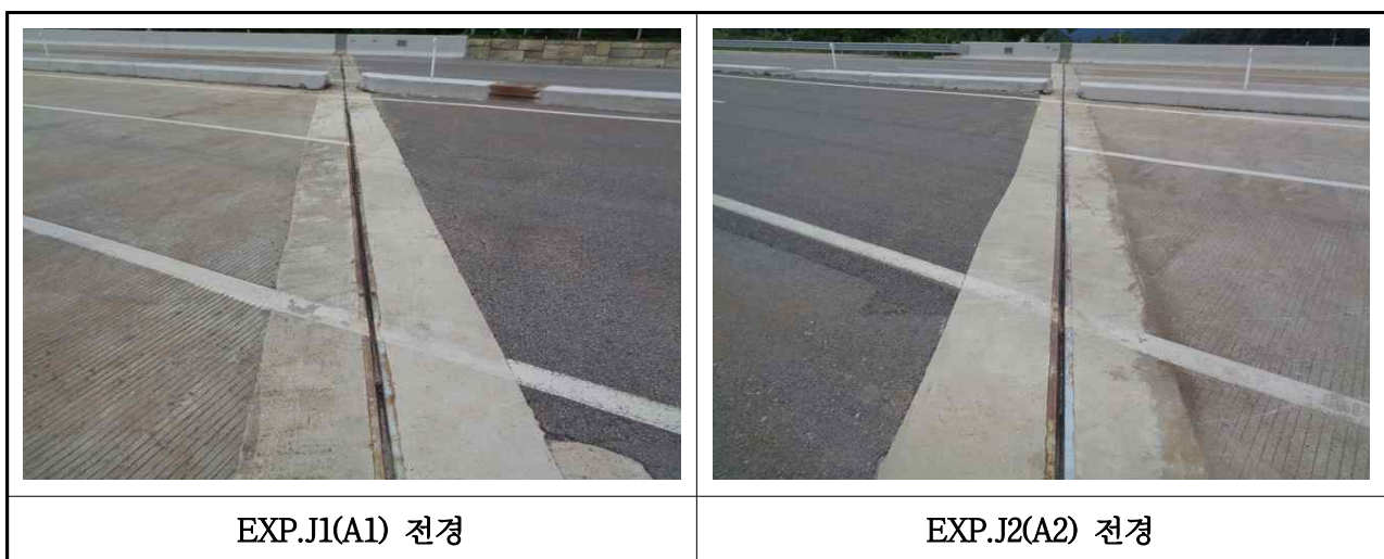
【사진 3.41】 신축이음장치 전경
