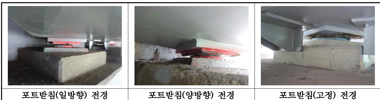
【사진 3.37】 교량받침 전경
