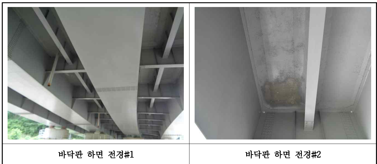
【사진 3.27】 바닥판 전경
