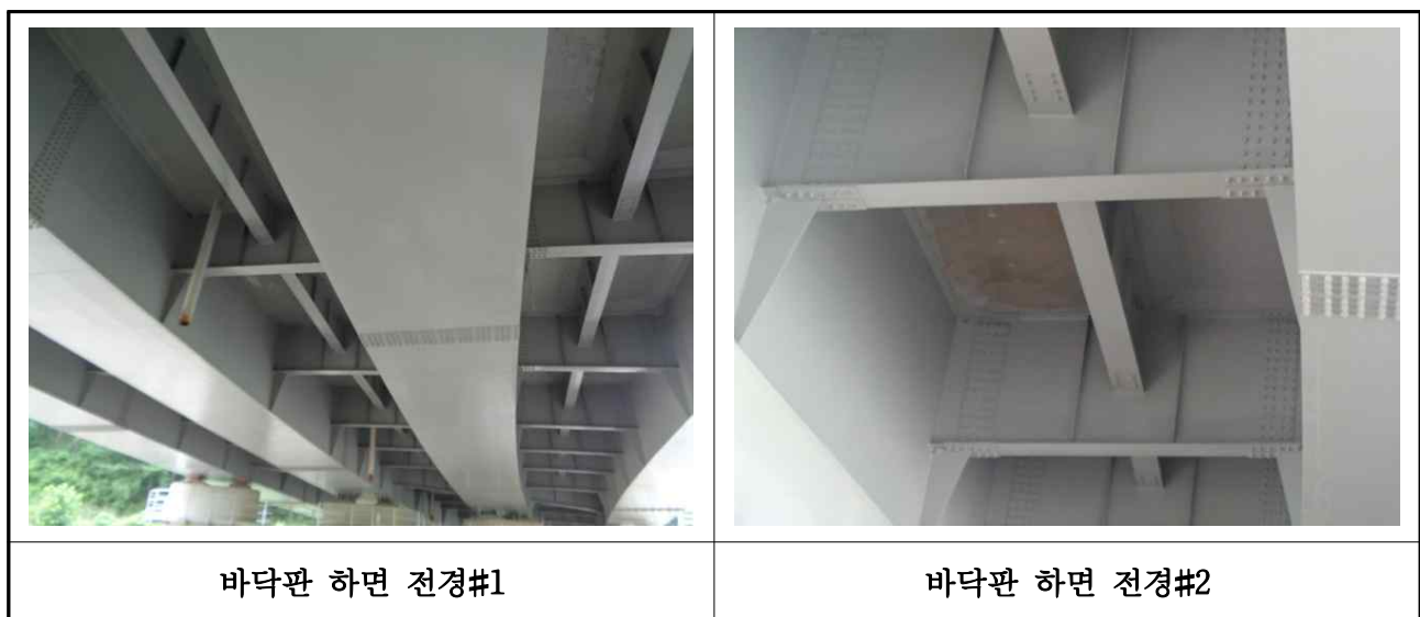
【사진 3.2】 바닥판하면 전경
